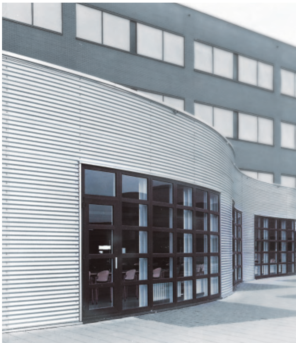
Ramen en deuren uit „vlakke“ Character-Design profielen in de praktijk
